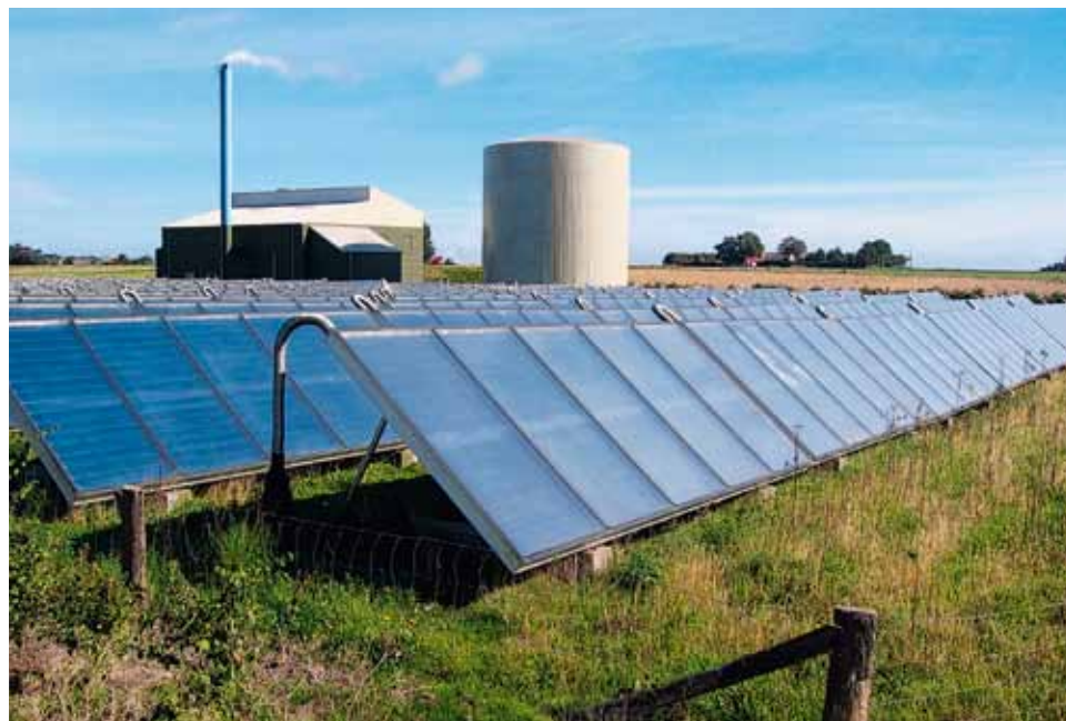
På norra Samsö kombineras bioenergi och solenergi i en fjärrvärmeanläggning som bland annat förser fritidshus med tappvarmvatten.
